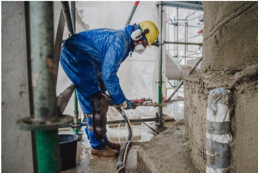
Herstelwerk door het opspuiten van passieve brandbeveiliging
