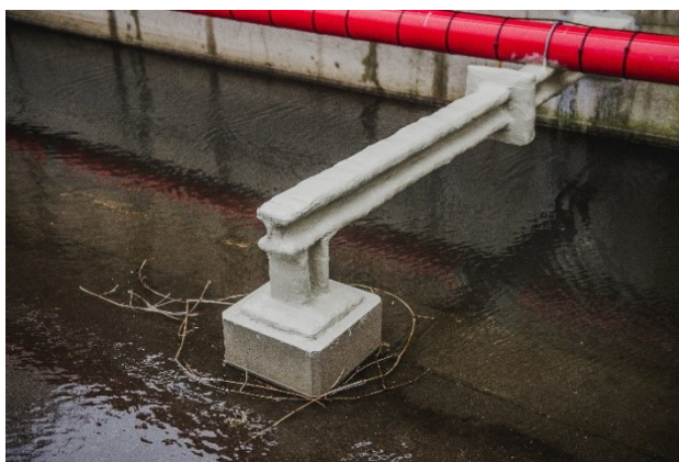
Leidingondersteuning voorzien van passieve brandbeveiliging
